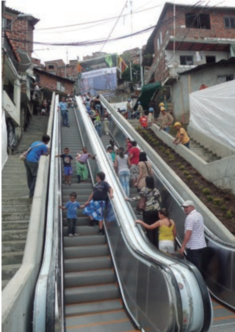
Escalera eléctrica en Medellín, Colombia. Foto: Diego Zamuner
